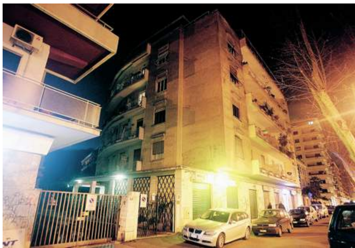
Il palazzo di viale Angelico 163 a Roma, sede legale della società Gpsc e dell'associazione Nens di Visco e Bersani
